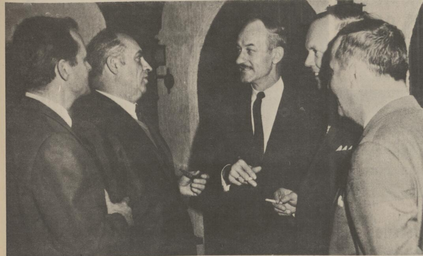
Plusieurs invités d'honneur ont assisté au lancement des travaux de fonçage des pieux-caissons du futur Hôpital du Haut-Richelieu, à Saint-Jean. Sur la photo, nous remarquons, de gauche à droite: M. Jérôme Proulx, député provincial du comté de Saint-Jean; le Dr. Vital Lavoie, prési-
