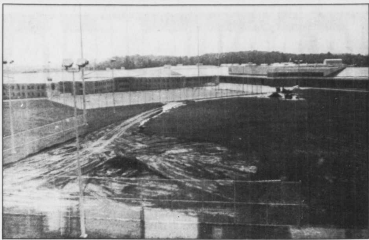
Le nouveau pénitencier fédéral de Donnacona accueillera dans les prochaines semaines, quelque 350 détenus. Cet immense pénitencier a été construit au coût de 56,5 millions de dollars. Il ouvrira ses portes d'ici à une quinzaine de jours.
