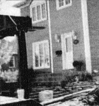
Des fondations pour des projets d'agrandissement sont réalisées par Mini-Excavation Ti-Nom.
