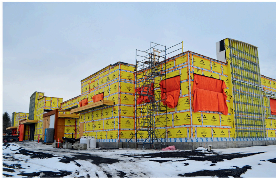
L'assemblage de la structure du nouveau magasin est déjà complété. (Photo: L'Avenir et Des Rivières)
