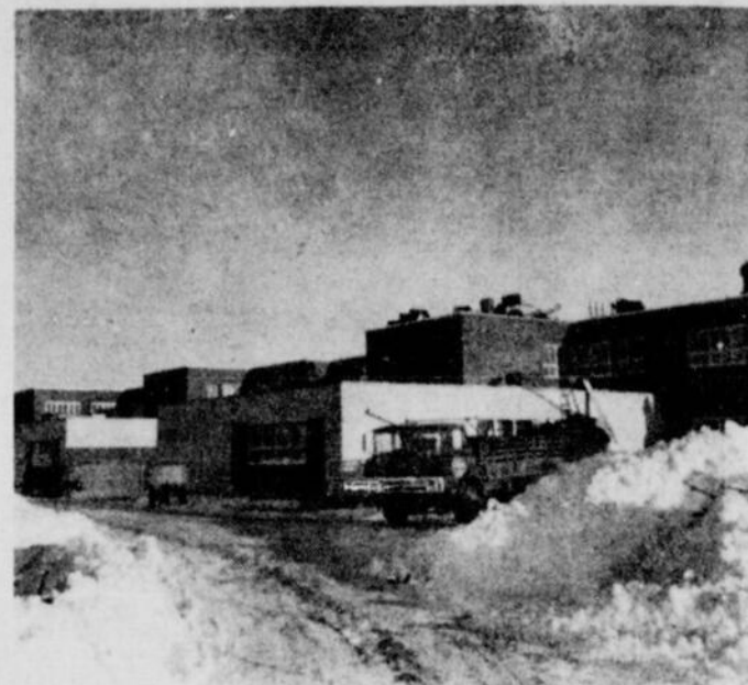
La construction du Centre Berthelet sera complétée en août 72.
