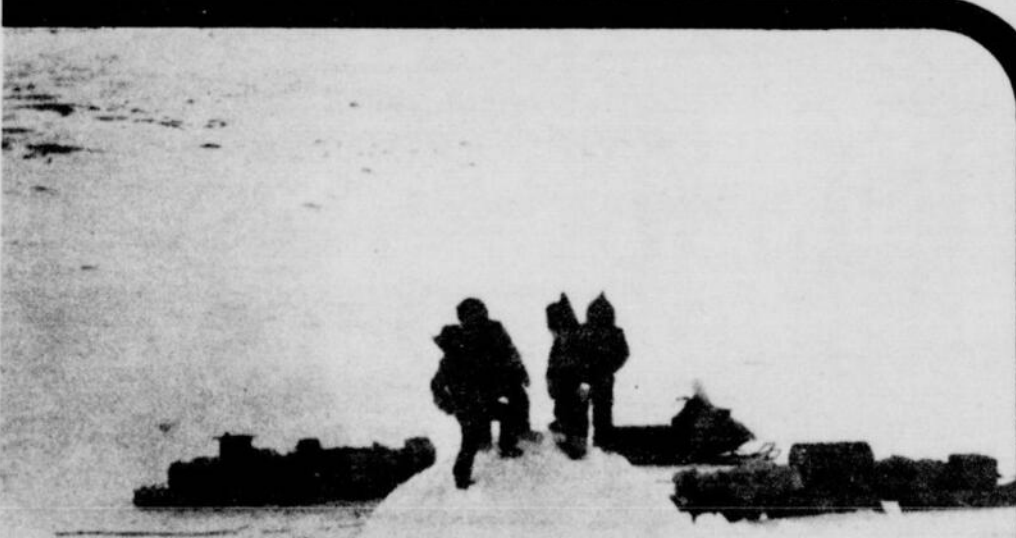
Un igloo construit en moins d'une heure est assez solide pour supporter quatre hommes.
