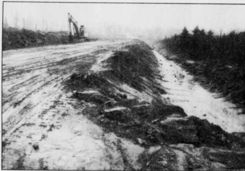
Une vue d'une partie du fossé de drainage périphérique aménagé sur le lieu d'enfouissement de Stone Consolidated à Saint-Georges-de-Champlain. Au second plan, une pelle mécanique au travail.
