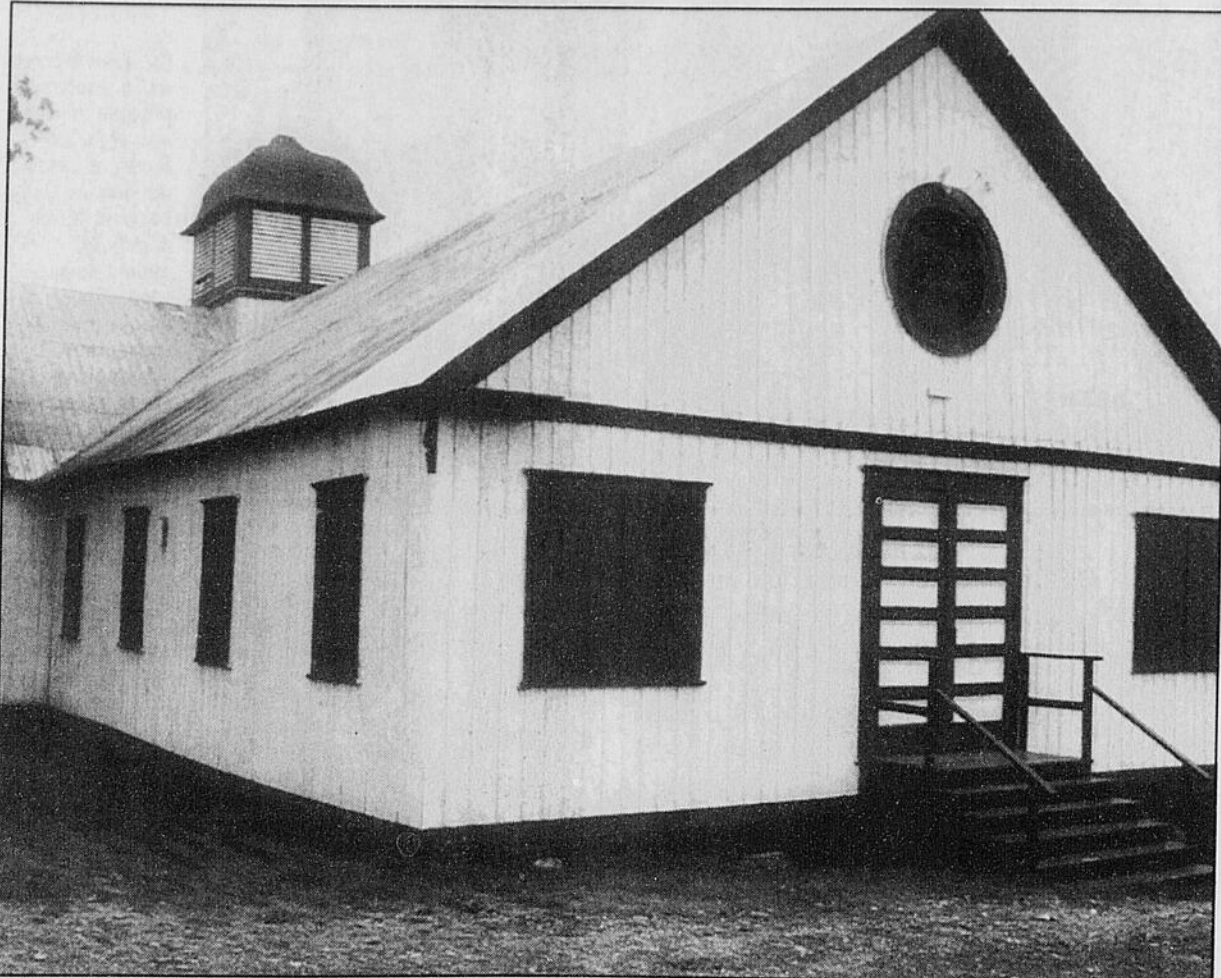
L'ancien poulailler devenu pavillon de l'artisanat est visé dans le cadre des démolitions envisagées par la Ville de Sherbrooke au plateau Parc.
