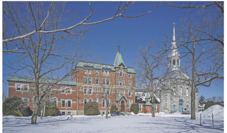
En matière de restauration d'immeubles patrimoniaux, la Ville a annoncé son intention d'intervenir à l'église Notre-Dame-du-Rosaire et au Monastère des Sœurs adoratrices du Précieux-Sang, deux bâtiments qu'elle possède déjà et qui s'inscrivent dans la vision d'un « pôle culturel » au centre-ville. Photo François Larivière | Le Courrier ©
