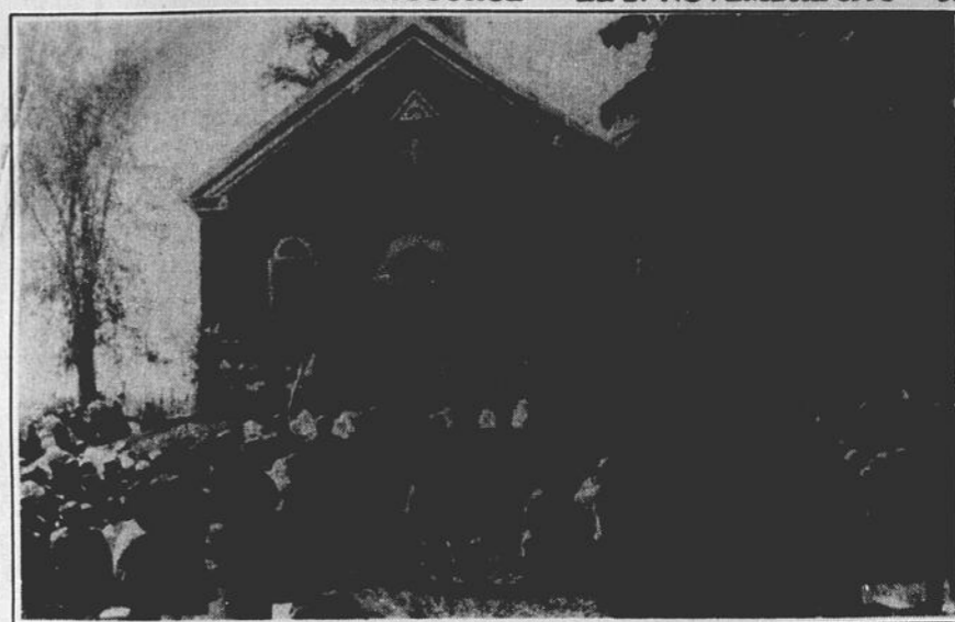
La première église Saint-Patrice de Hinchinbrooke avant qu'elle ne soit détruite en 1936 par un incendie provoqué par la foudre. (Photo : A.M.)
