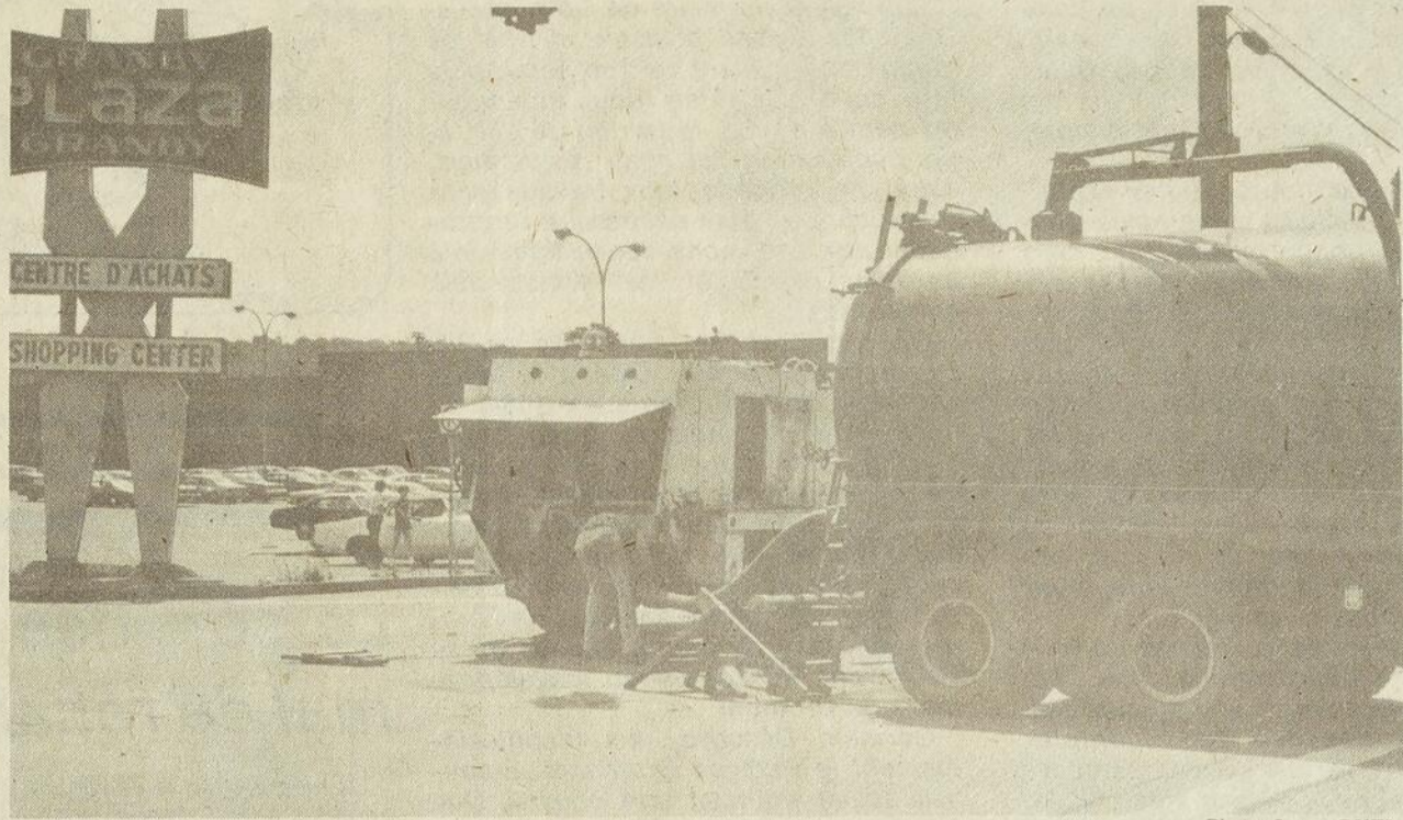
Même ce qui ne paraît pas sera propre. Sur la rue St-Charles, on s'affaire au nettoyage des conduites d'égout.
