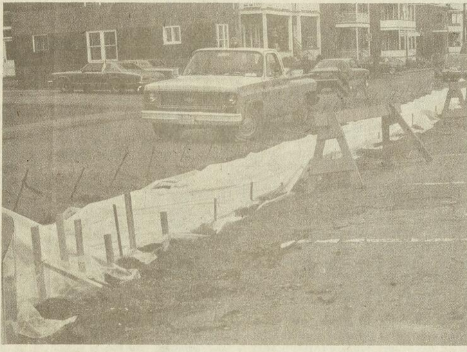
Sur la rue Bréboeuf, à partir de l'intersection de la rue Principale, on a refait le trottoir.
