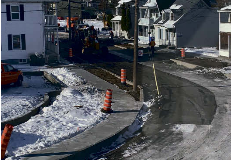
L'asphaltage a débuté le 18 novembre. Photo gracieuseté
