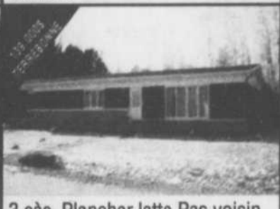
3 c.à. Plancher latte Pas voisin arrière Boisé Grand terrain Transfert. 12,300 p.c.
