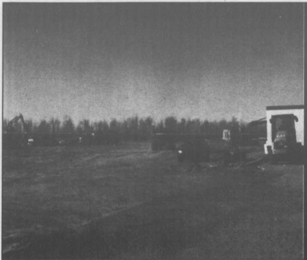
Les travaux ont commencé sur le site du futur Centre de distribution RONA à Terrebonne.
