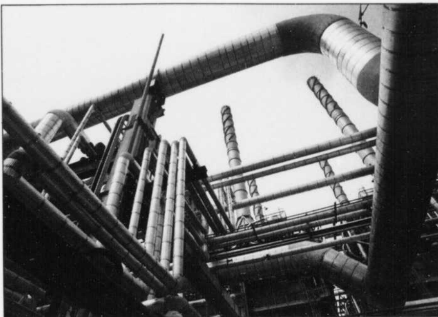
1 Les températures atteignant 900°F, le Thermo 12 au silicate de calcium était l'isolant qui convenait.
