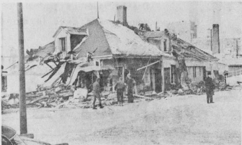
UN DEMI-SIÈCLE, C'EST SUFFISANT — Le vieux restaurant du port et l'ancien local des débardeurs qui étaient abrités sous le même toit, ont terminé leur existence hier. Une équipe d'ouvriers à l'aide de camions et de chaînes reliées aux poutres principales, ont fait de jeter l'édifice cinquantenaire à terre. À la suite de cette démolition, les débardeurs jouissent maintenant d'un nou-
