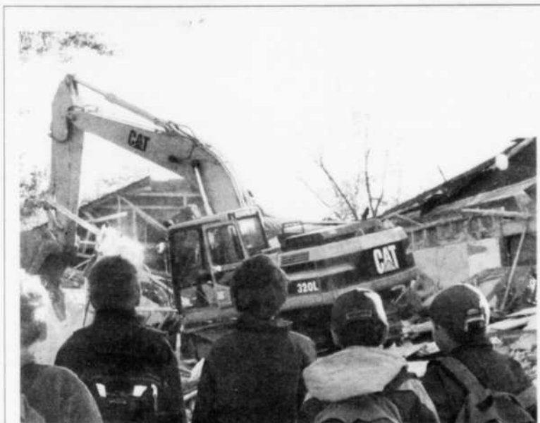
DÉMOLITION — Il est toujours impressionnant de voir démolir une bâtisse, ou une section de construction qui fait partie du décor depuis des années. C'était le cas, cette semaine, à côté de l'ancienne école Arc-en-ciel d'Alma, au 200 avenue McNaughton, d'autant plus que les spectateurs n'étaient pas très grands et sans doute pas habitués à ce genre de spectacle. Mercredi prochain, le Centre de la petite enfance La Bambinerie d'Alma y vivra la levée de la première pelletée de terre de sa nouvelle installation, à savoir une garderie de 60 places.
