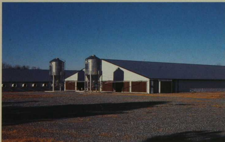
Les bâtiments modernes sont conçus pour limiter les besoins en main-d'œuvre et pour améliorer les conditions d'élevage et les performances en général.
