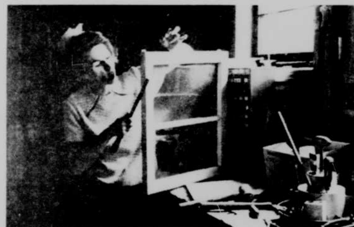
Les fenêtres ont "travaillé"? Un p'tit coup de rabot ou de grosse lime et tout rentre dans l'ordre... et dans les cadres.
