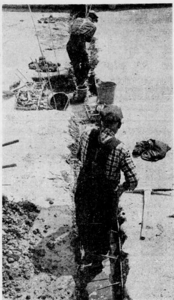
En viendront-ils à bout? — Ce ne sont pas les enfants, mais les employés de la cité qui barbotent dans la piscine du parc Sangster pour installer un système de drain qui empêchera l'eau de s'y infiltrer. On sait que cette piscine a causé beaucoup de soucis aux édiles et qu'en fin de semaine, un enfant a failli se noyer dans l'eau qui s'y était infiltrée par le dessous.
