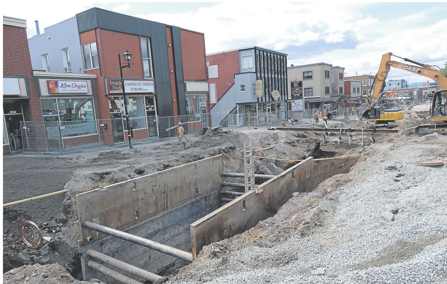
La présence de la machinerie lourde et les travaux d'excavation ont transformé, depuis un mois, une partie de la rue Principale à Granby en chantier. — LA VOIX DE L'EST, ALAIN DION
