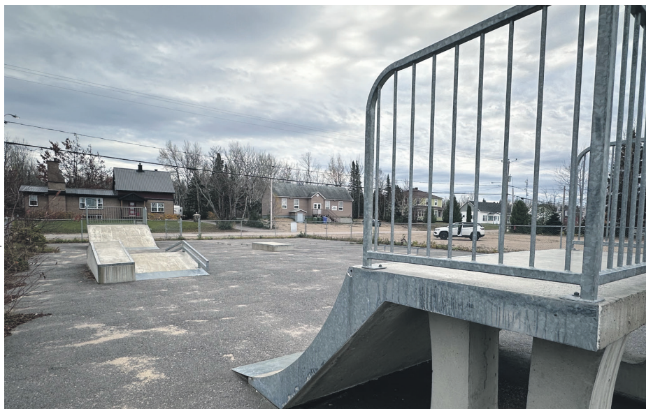
L'asphalte du parc de planche à roulettes de Colombier sera entièrement remplacé par une surface de béton lisse. Photo Johannie Gaudreault
