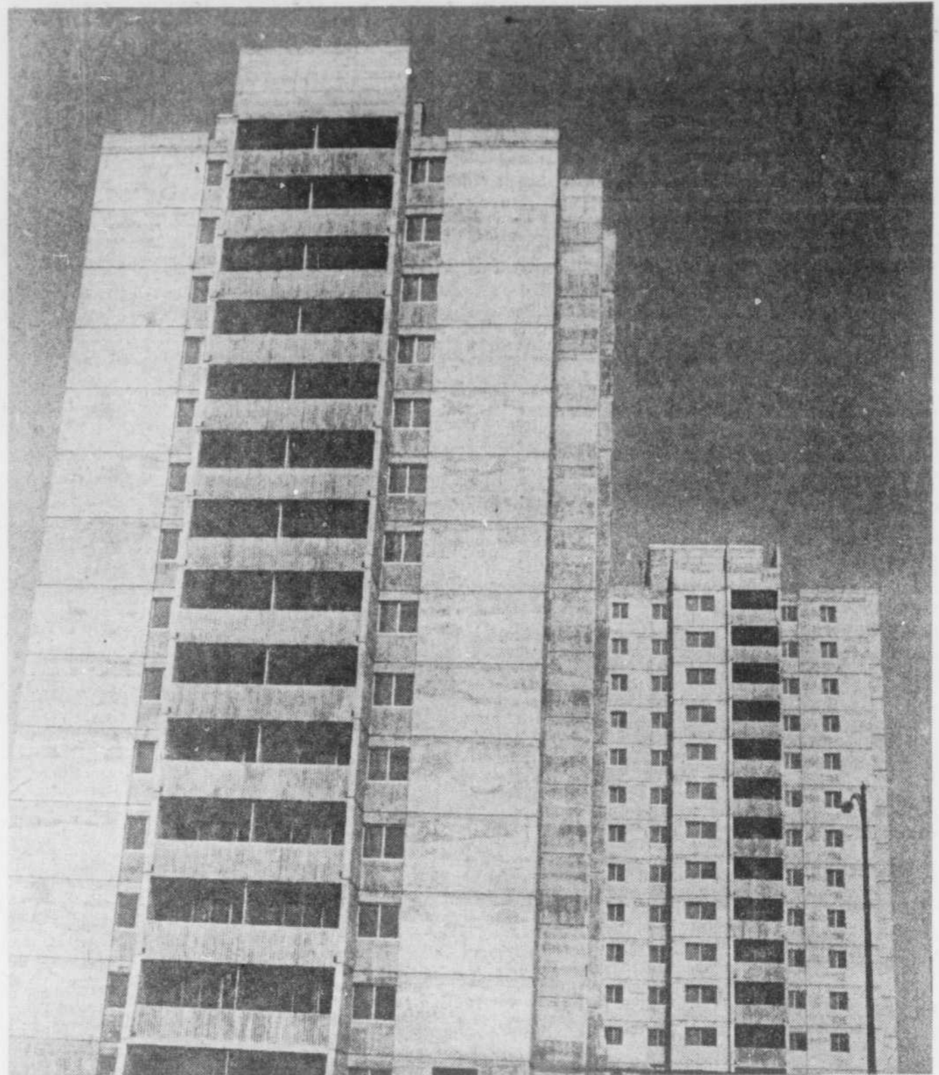
Une autre réalisation de la Société d'habitation du Québec.
