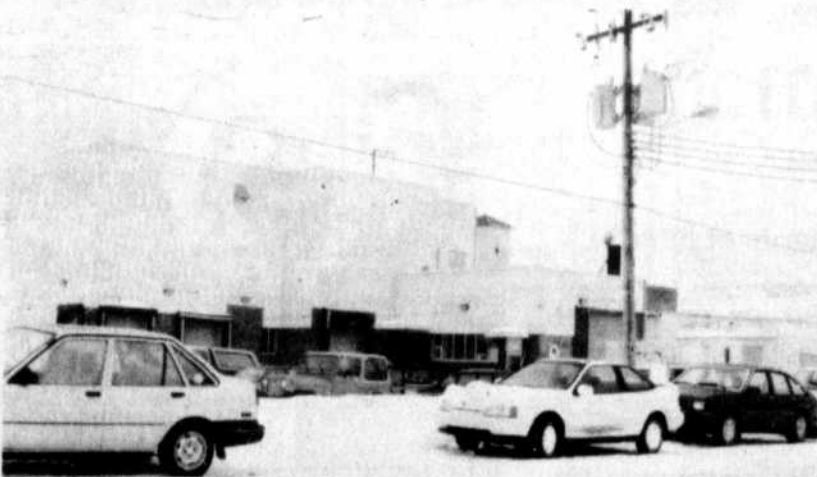
Les travaux vont bon train à l'usine de transformation de poissons dont l'entrée principale est située sur la rue St-Laurent.
