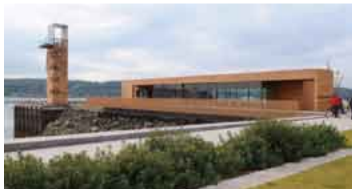
Station des cageux
