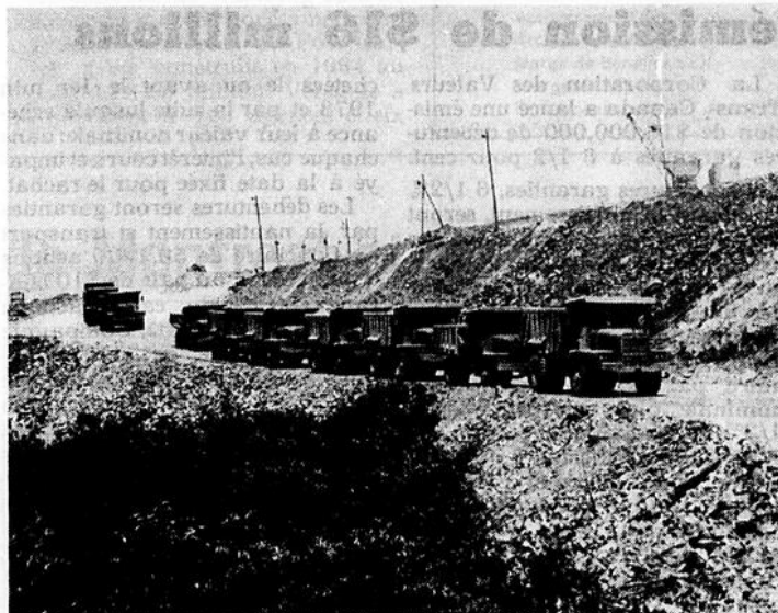
Ces camions, qui servent à la construction du barrage de Mactaquac sur la rivière Saint-Jean, au Nouveau-Brunswick, sont munis de bennes légères fabriquées par la Société Atlas Hoist de Montréal. Les bennes sont formées d'aluminium Alcan 74S, nouvel et solide alliage dont la légèreté permet d'augmenter la charge utile de vingt pour cent.
