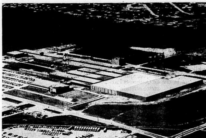
La vue aérienne des installations de la société 3M à London montre l'ampleur du nouvel agrandissement, à droite de la vignette, en gris foncé.
