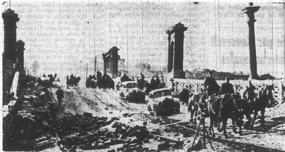
Les divisions motorisées allemandes durent trouver un autre chemin pour traverser cette rivière sur le front russe et fuir devant les armées soviétiques après que le pont eut été gravement endommagé par les bombardements. Les voitures légères purent passer sur le pont.
