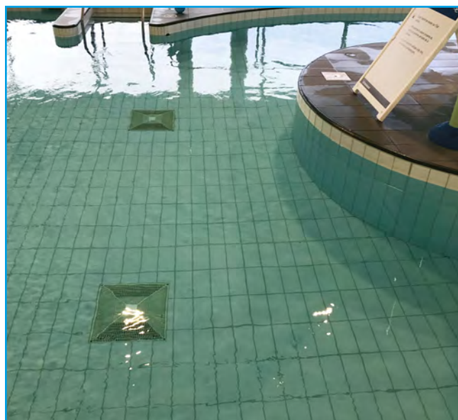
Figure 45. Drains de fond
