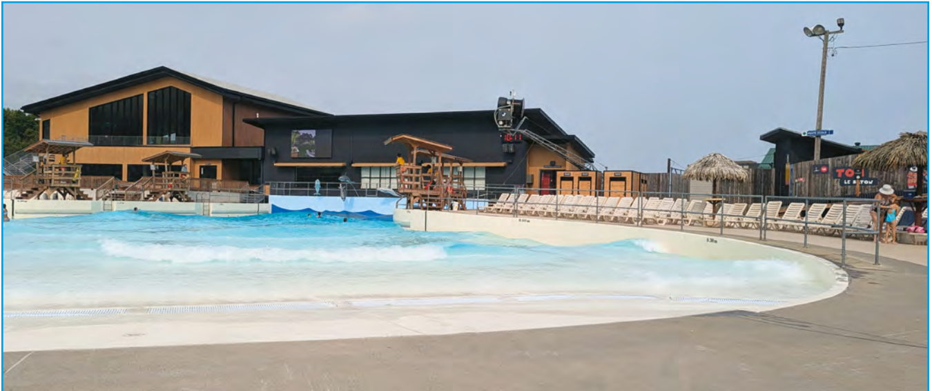
Figure 6. Piscine à vagues
