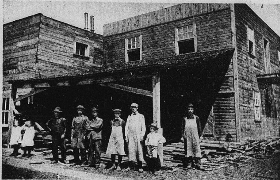
1904 Manufacture de M. JOSEPH PILON situé au 294, rue Champlain, Hull, (anciennement 294, rue Inkerman). Nous voyons sur la photo M. Jos Pilon à l'extrême droite.
