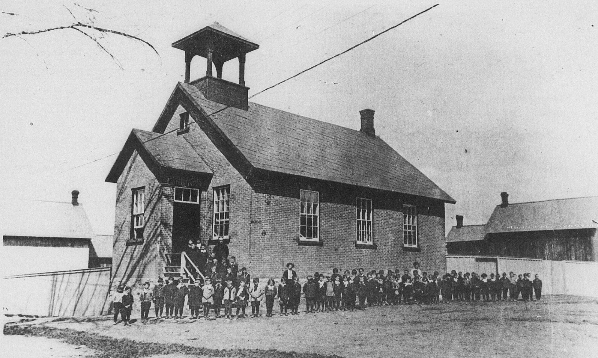
L'école Ste-Anne a été l'une des premières écoles à être construites à Hull, dans le premier quart du 20e siècle, après le grand feu de 1900
