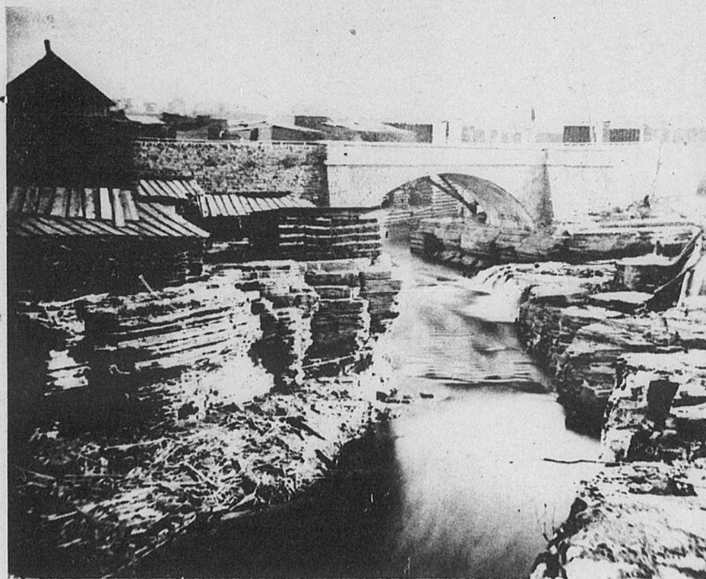
Le pont Chaudières tel qu'il apparaissait dans le dernier quart du siècle dernier. L'eau et le roc étaient alors encore visibles. Une première version, construite en 1828, s'écroulait 8 ans plus tard et ne fut remplacée que 7 ans après, en 1843. (Photo Archives du Canada PA 12528)
