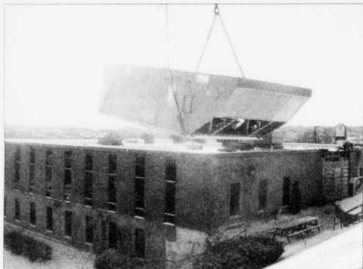
Beaudin Le Prohon a réalisé les travaux pour la ventilation, la climatisation, les centrales d'air géothermique et les unités de toit pour l'édifice de Cima+ en 2008-2009.
