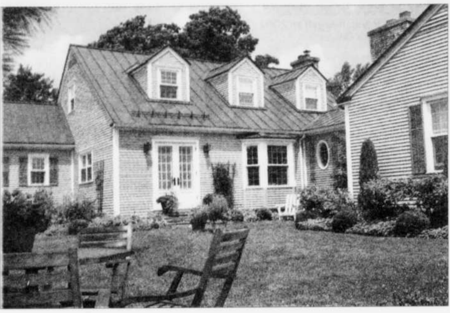
En 2005, une toiture d'acier avec arrêt-neige a été réalisée par le Groupe Luc Fauteux.
