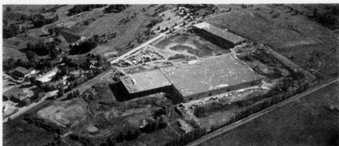
C'est Toitures P.L.M. qui a fait la toiture pour le projet Cargo Village Dorval en 2008.
