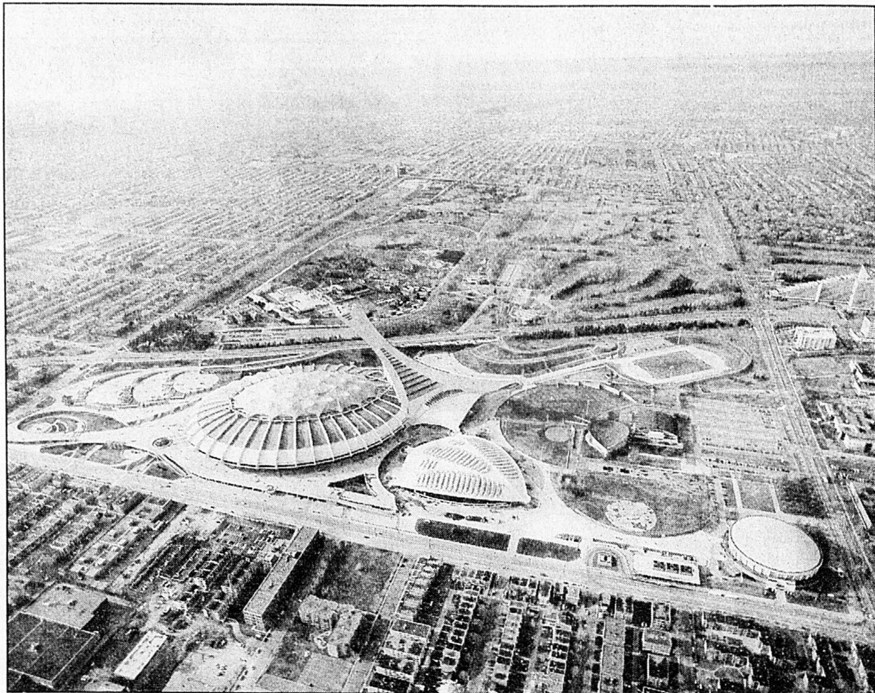
Selon le plan de développement de la RIO, le terrain vague à la droite du futur Biodôme pourrait accueillir un hôtel de 250 cham-
