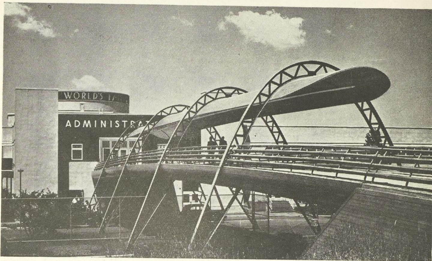
L'édifice qui renferme les services administratifs de l'Exposition est situé juste en dehors des limites de l'Exposition. Le « Pont de demain » relie le second plancher de ce pavillon au terrain de l'Exposition.
