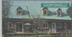
ST-FULGENCE: 4, rang St-Joseph. Maison de campagne, construction tout bois int. et ext. *Hélène Turgeon: 418-590-1818
