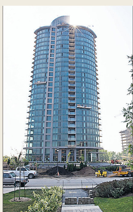
La phase 1 du Vistal, une tour vitrée de 25 étages, est presque terminée. La phase 2, identique, sera érigée juste à côté.
