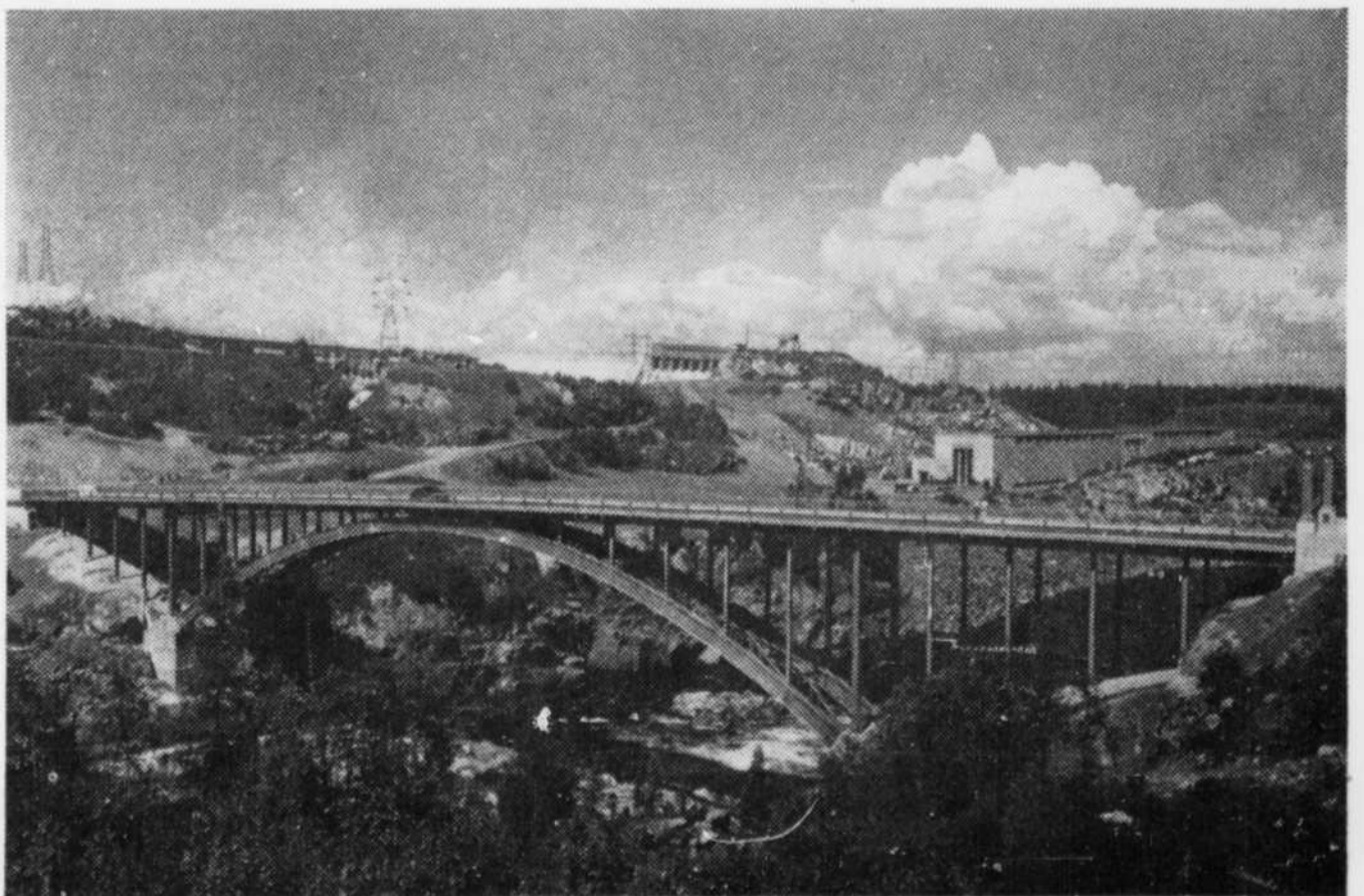
VUE DE LA CENTRALE NO 2 DE SHIPSHAW. Au premier plan, le pont Arvida entièrement construit en aluminium.
