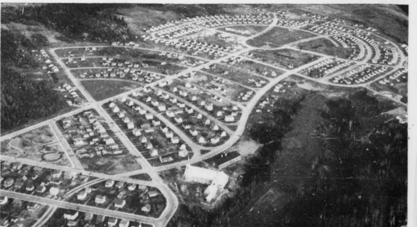
VUE AERIENNE d'une des plus récentes sections d'Arvida, celle des maisons de guerre qui a été ouverte au cours des années 1942 à 1945. L'on remarquera les deux bras de l'Y formés par les rues Bégin et Racine. De chaque côté et au centre s'échelonnent les maisons de ce quartier résidentiel.
