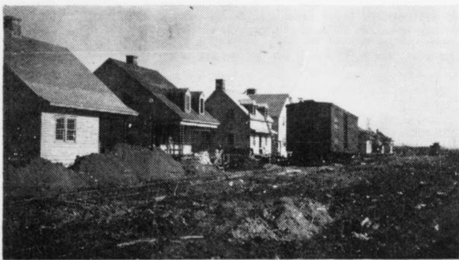
CETTE PHOTO PRISE il y a 25 ans nous montre comment l'on apportait les matériaux employés à la construction des premières maisons d'Arvida. Une voie ferrée avait été installée à partir de l'ancien atelier de menuiserie (planning mill) rue Hall et passait à travers le parc Moritz pour descendre la ruelle des Cèdres et se continuer sur la rue Moissan avec embranchement sur la rue Deville. La photo ci-dessus, qui a été prise sur la rue Deville, en direction de la rue Volta, nous fait voir, à gauche, les maisons de MM. Steve Vasil (309), René Tardif (311) et Mme William McNutt (313). La devanture de la maison de M. Vasil a été complètement transformée depuis.
