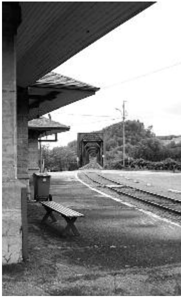
La gare de vallée Jonction en Beauce.
