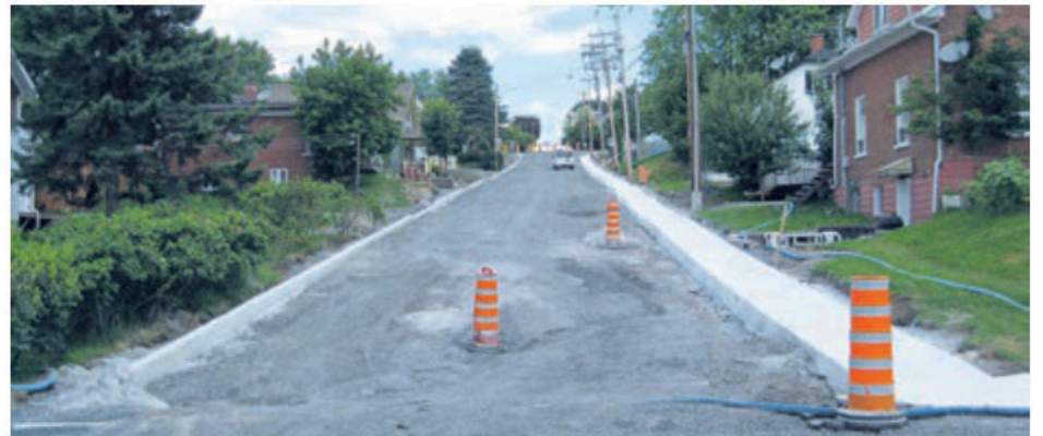
Des travaux similaires à ceux qui seront réalisés prochainement sur cinq tronçons de rues avaient été effectués en 2013 dans la 127e Rue. (Photo Ville de Saint-Georges)
