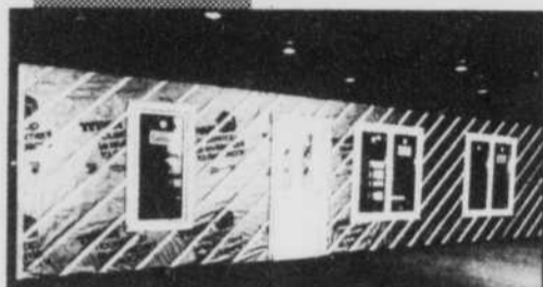
Murs en panneaux isolés faits en usine et érigés sur le site.
