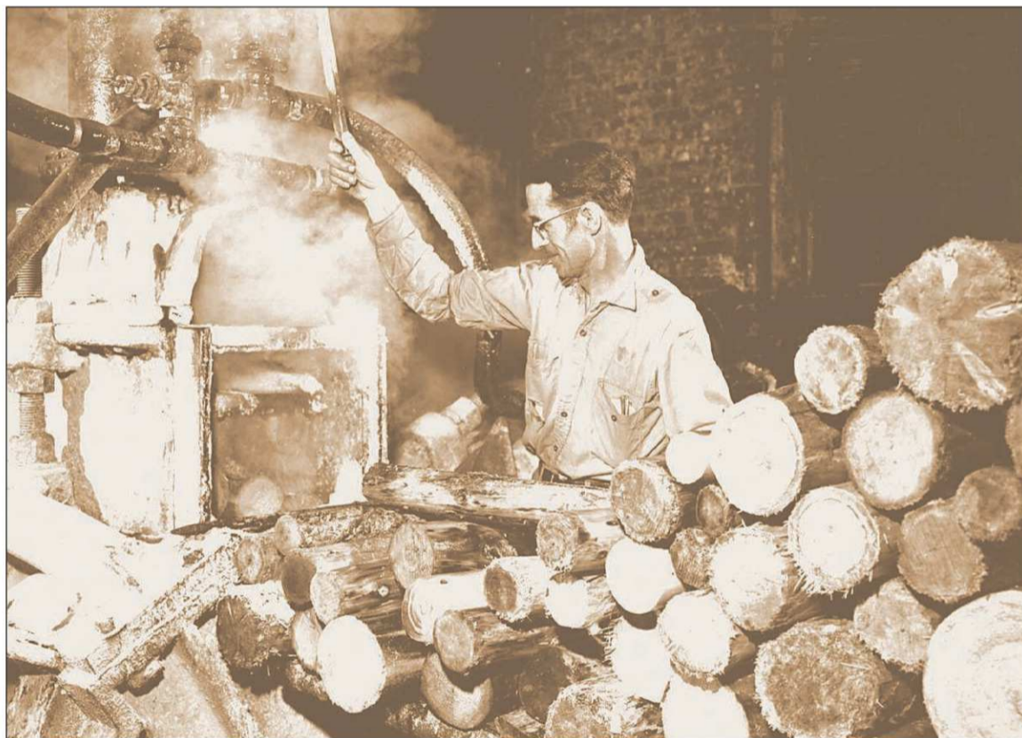
Sur cette photo prise en 1941, un opérateur charge une meule hydraulique avec du bois de deux pieds. À l'époque, le moulin à papier n'appartenait pas à Kruger. Il s'appelait Brompton Pulp and Paper Co Ltd et était la propriété de St. Lawrence Corporation.
