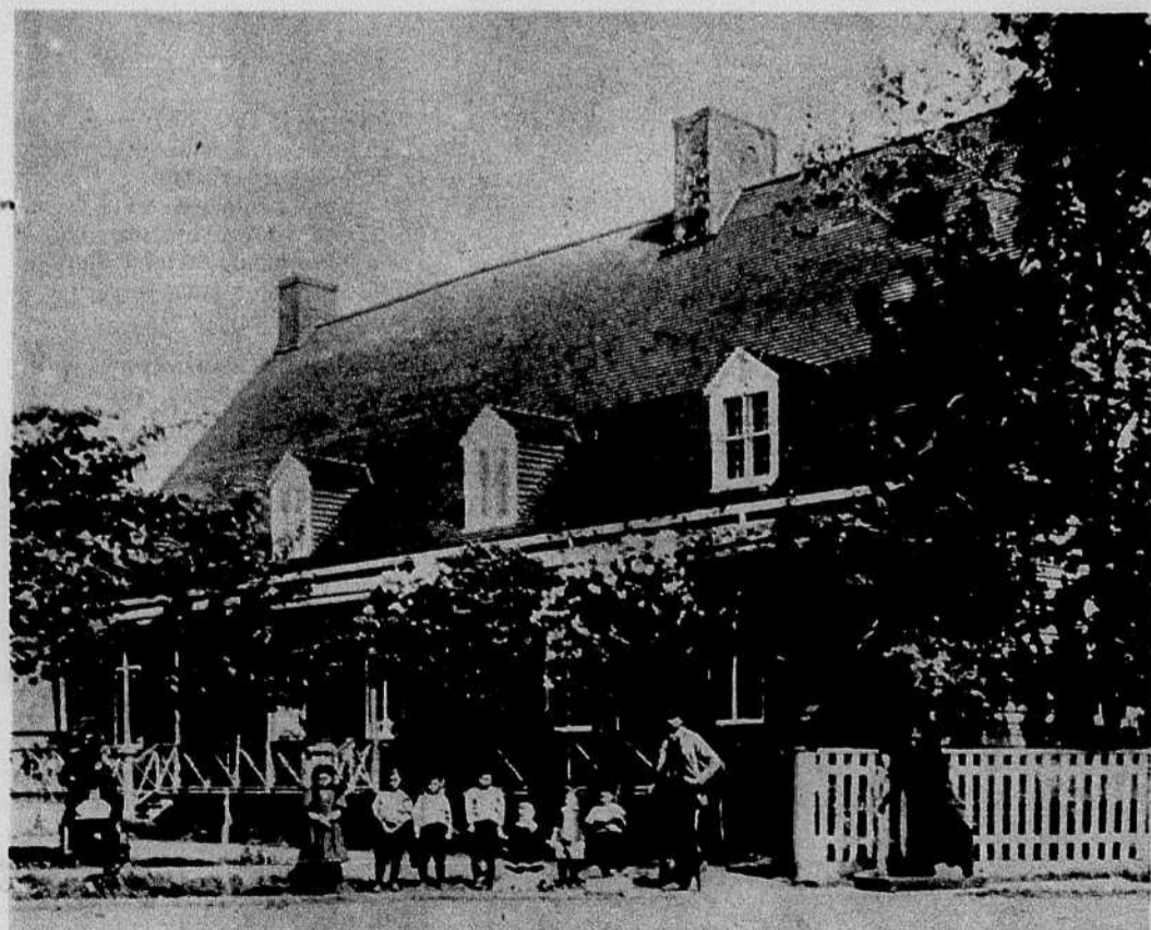
Le manoir Couillard-Dupuis se dresse à l'embouchure de la rivière du Sud, à Montmagny. Construit de pins blancs retenus par des chevilles de bois, il a défié le temps. Nos ancêtres construisaient solidement.
