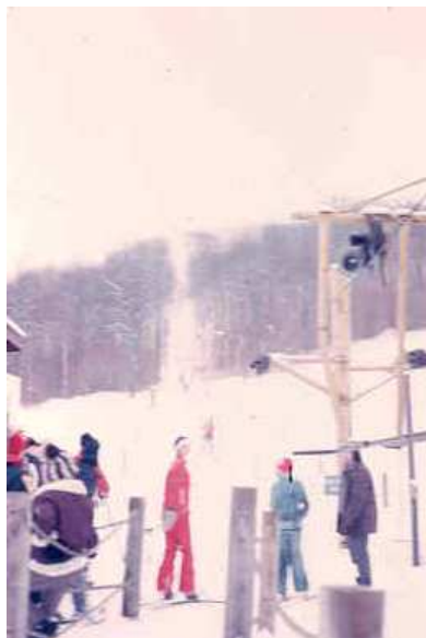
Installations du Mont-Daniel, à Saint-Aimé-du-Lac-des-Iles.
