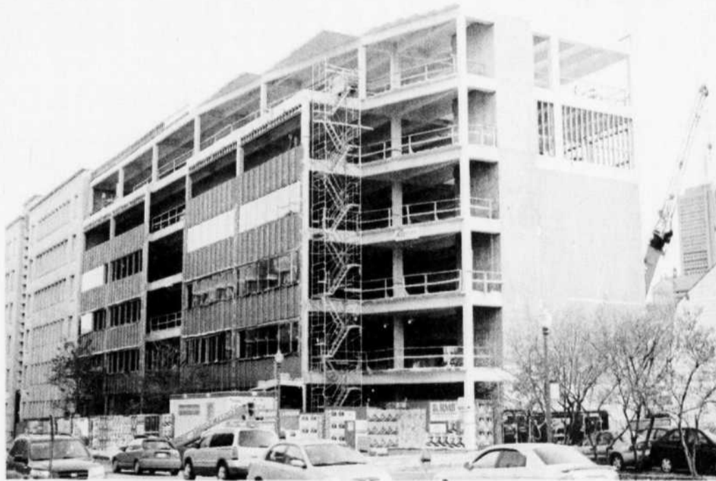
CHANTIERS CHIBOUGAMAU-NORDIC STRUCTURE BOIS Chantiers Chibougamau a notamment produit des structures pour une tour à bureaux de six étages du FondAction de la CSN à Québec, une première en Amérique du Nord.
