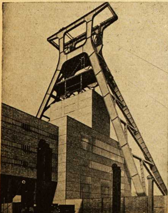
A Essen, un établissement de surface de la mine Zollverein 12, reconstruite depuis la fin de la guerre.
