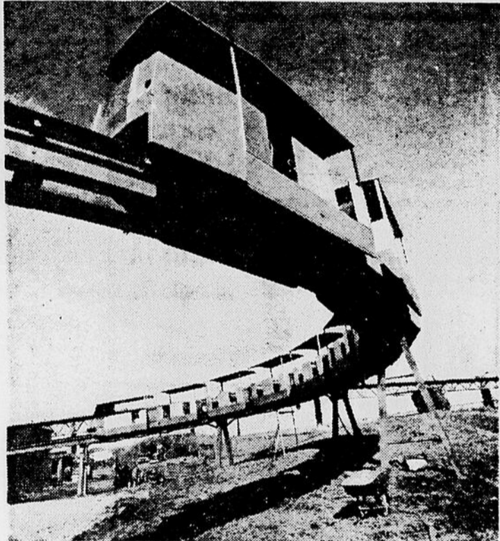
Le réseau auxiliaire de transport en commun de l'Expo 67 comprendra un "minirail". Monorail en miniature, le "minirail" comporte des wagons ouverts, pouvant transporter 12 personnes chacun en roulant sur un rail unique.
