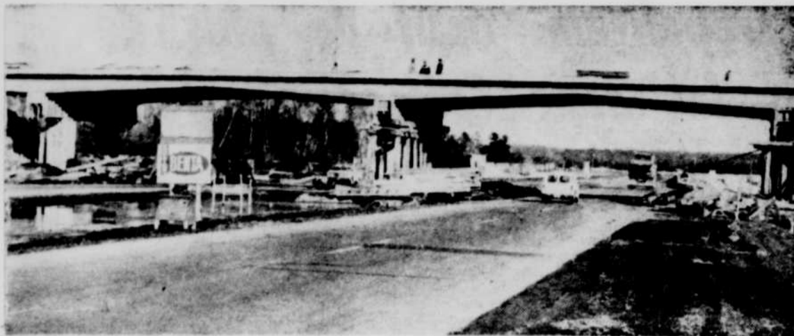
Ce viaduc a été le premier à être construit sur la Transcanadienne, près de Drummondville.
