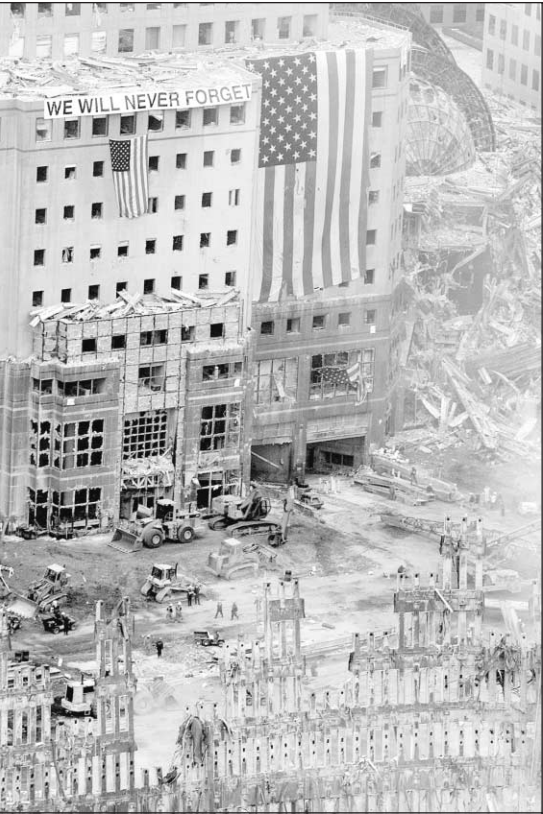
Un drapeau américain accroché sur les flancs endommagés de l'édifice d'American Express, à New York.
