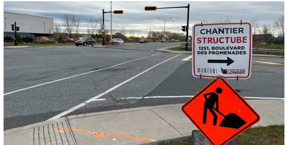
Des travaux de raccordement liés au chantier de Structube occasionneront des entraves sur le boulevard des Promenades. (Photo : Frank Jr Rodi)
