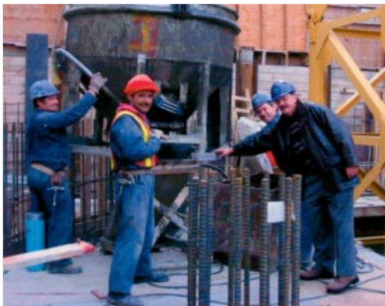
Henri Massé, président de la FTQ, visite le chantier de la nouvelle tour, à l'angle du boulevard Crémazie et de la rue Lajeunesse.
