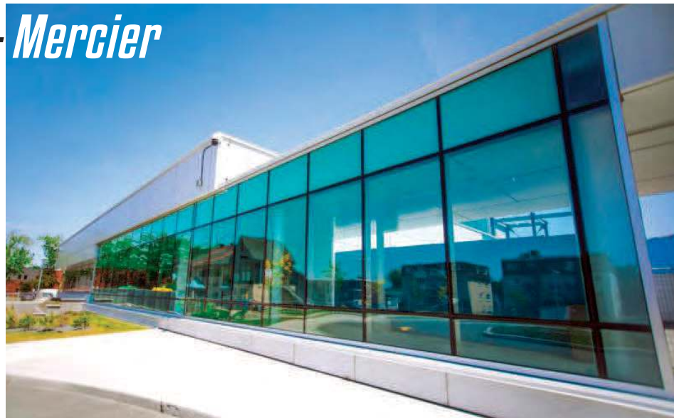
Le projet de 69 millions de dollars consistait en un agrandissement d'une superficie de 6 516 m 2 , sur deux niveaux.
