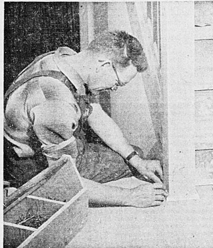
LE POINT FINAL. — Habituellement, si la boiserie doit être peinte, il n'est pas nécessaire que le bois employé soit de qualité supérieure comme s'il devait être verni. Toutefois, du bois de construction avec des noeuds peut être employé avec un fini clair pour donner un effet rustique.
