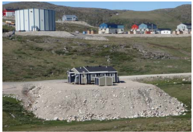
PHOTO 2 - La construction sur radier nécessite une grande quantité de granulats.
