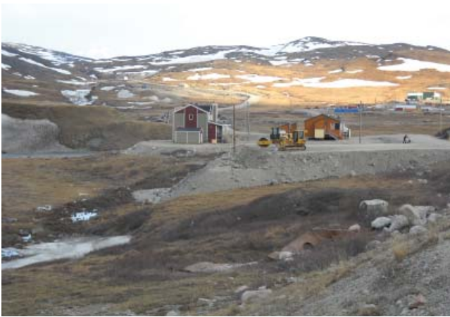
PHOTO 1 - Construction sur radier (remblai granulaire).
