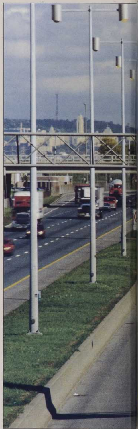
Première étape de la révolution électronique de la circulation: les panneaux à messages variables, installés sur le réseau autoroutier de la région de Montréal.
